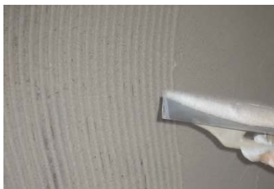
Première couche sur l'isolation
