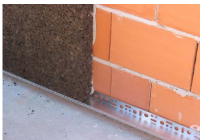
Application du panneau de liège et profilés
