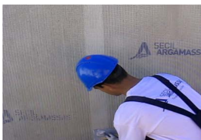
Application de treillis en fibre de verre sur ADHERE Vit ecoCORK
