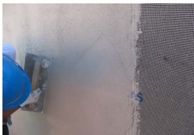
Réalisation de couche de régularisation
