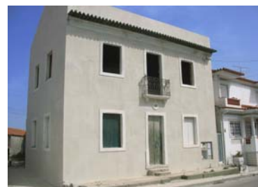
Aspect final du mortier
