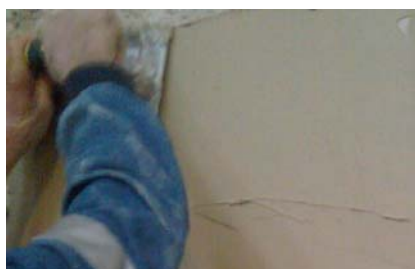
Application de REABILITA Cal Acabamento
