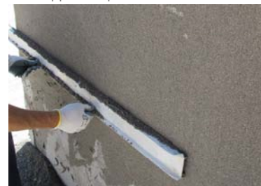
7. Nivelage de la surface à l'aide d'une règle
