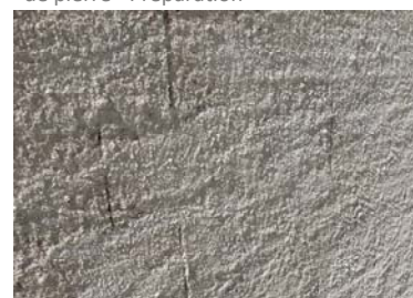
4. Maçonnerie de brique céramique préparée avec crépi de REABILITA CAL Consolidação
