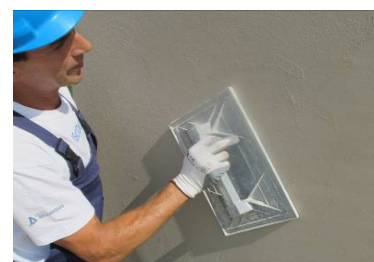
11. Talochage de la surface finale de REABILITA CAL Acabamento
