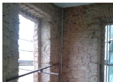
1. Support en maçonnerie de brique céramique ancienne
