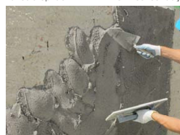
6. Application manuelle de Secil ecoCORK lime sur support crépi.
