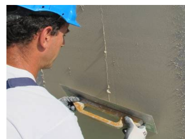
10. Application de la première couche REABILITA CAL Acabamento
