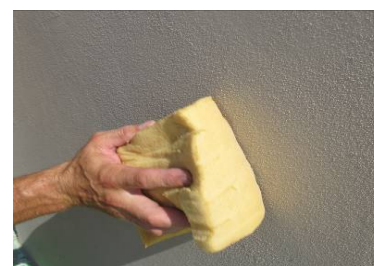
12. Lisser à l'éponge la surface pour obtenir une finition sablée fine
