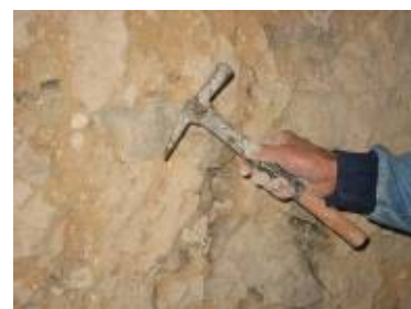
3. Nettoyage de Support en maçonnerie de pierre - Préparation
