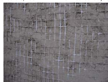
5. Maçonnerie ancienne de pierre préparée avec crépi de REABILITA CAL Consolidação
